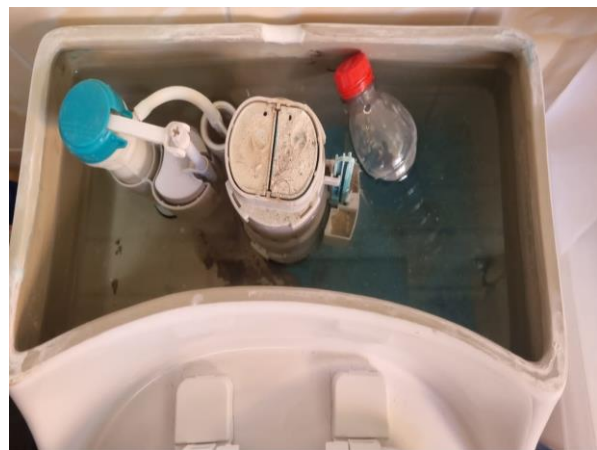
Colocación de botellas de agua en inodoros
